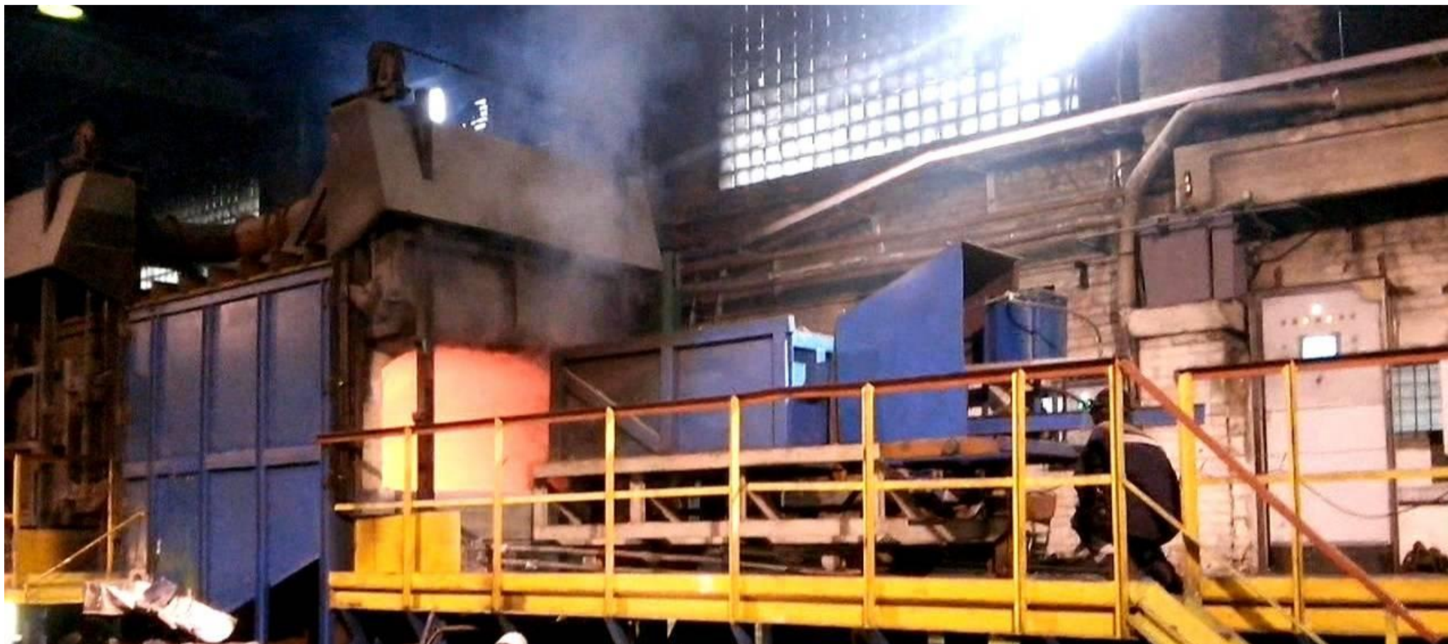
Фото 2. Загрузочная машина подъезжает к загрузочному окну печи
